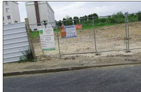
AMÉNAGEMENT. Un grand terrain en friche a été coupé et deux maisons vides abattues pour laisser place à 16 pavillons.
